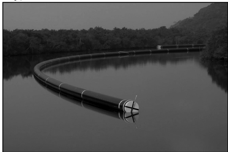
Novos tubos serão acoplados à tubulação já instalada no Lago Guaíba
