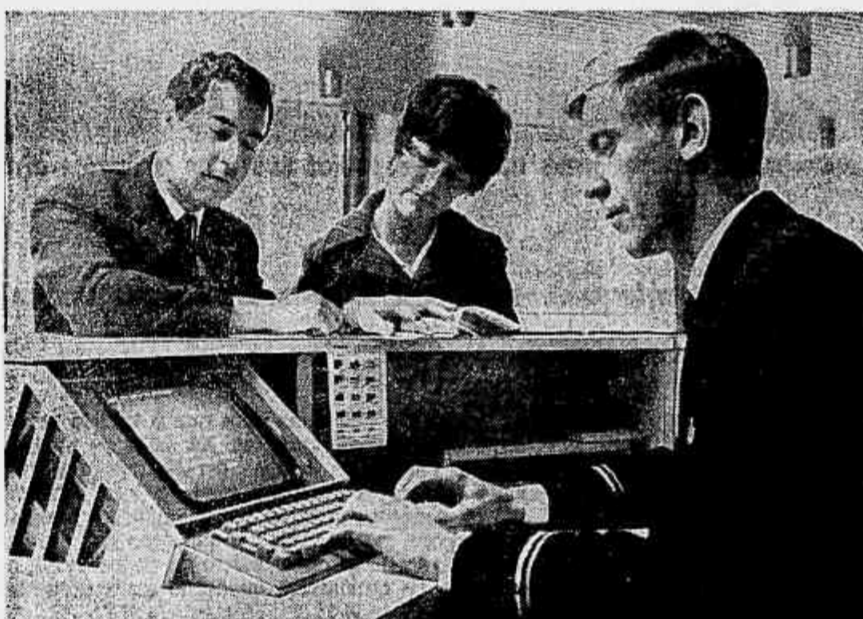
Esta é uma das unidades do novo sistema de processamento de dados da BOAC, que dá ao passageiro informação instantânea sobre horários de vôos e disponibilidade de lugares. Em menos de três segundos o computador atende ao usuário, que procura a agência da companhia para saber detalhes do seu vôo.
