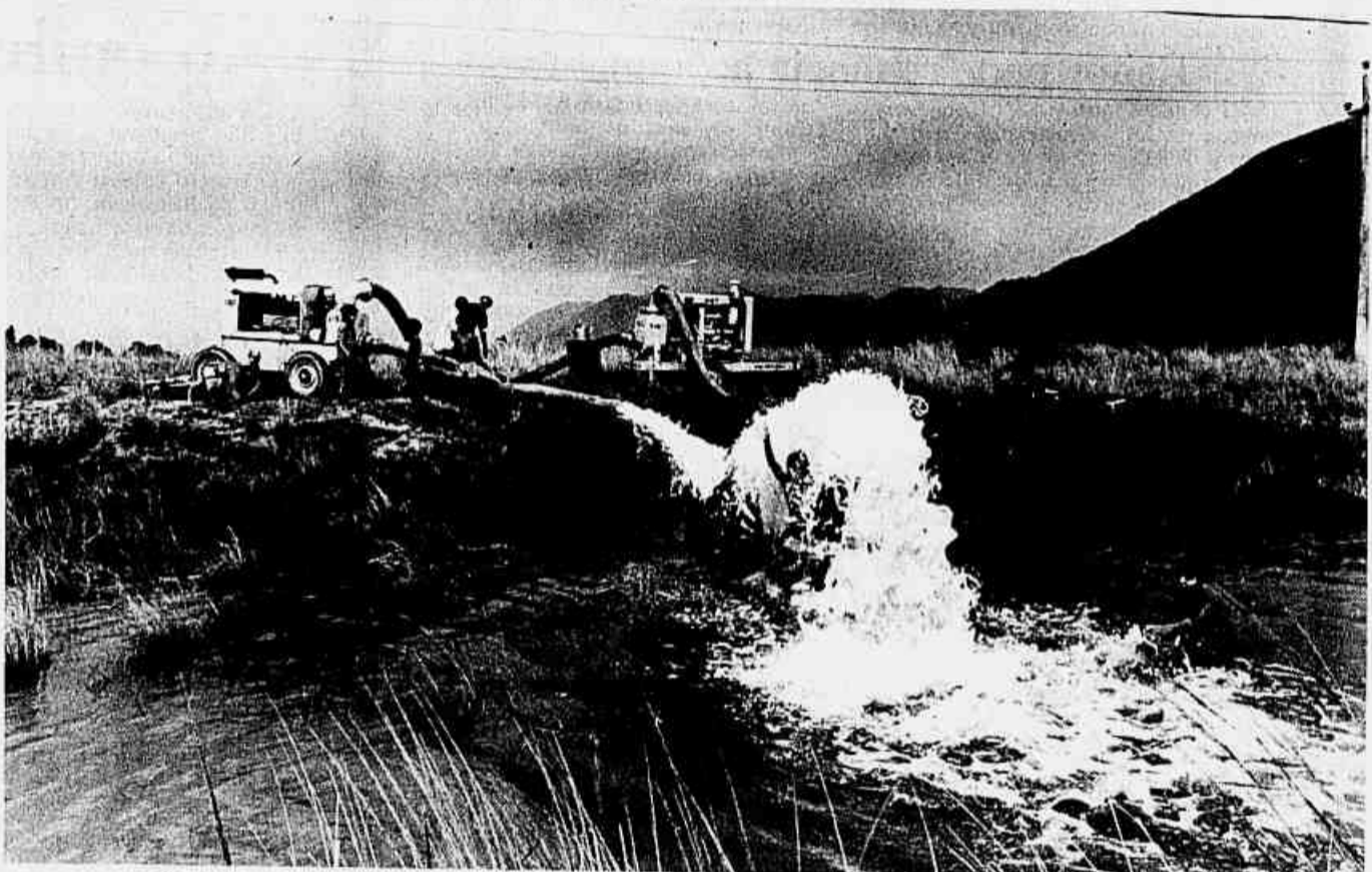
As crianças refrescaram-se no chafariz e no lago artificial formados pelo bombeamento da água das tubulações da adutora do Guandu
