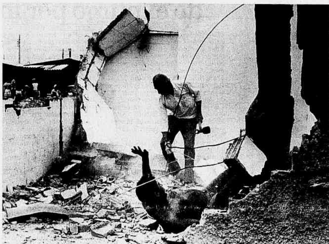
tijolo, telha ou vergalhão. Atingido por um bloco de concreto ele caiu junto a um encarregado da demolição, enquanto outros
