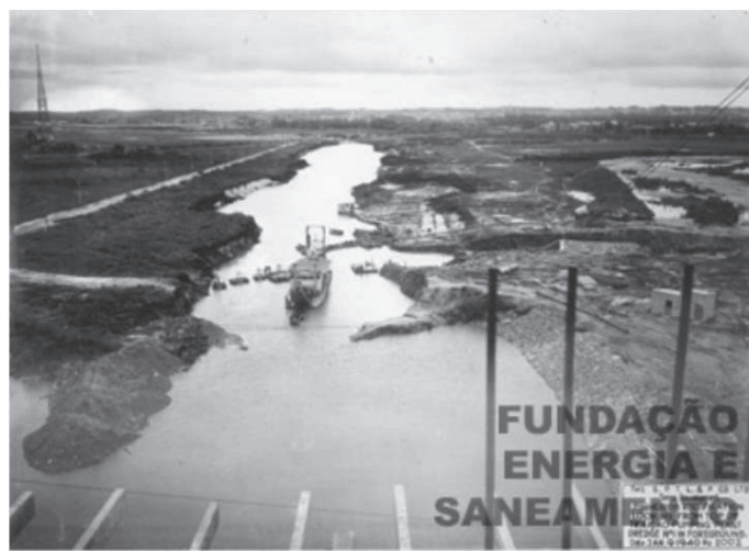
Legenda: Retifica o do rio Pinheiros vista de cima da usina de bombeamento de Trai o. Draga n  1 draga em primeiro plano. 1940
