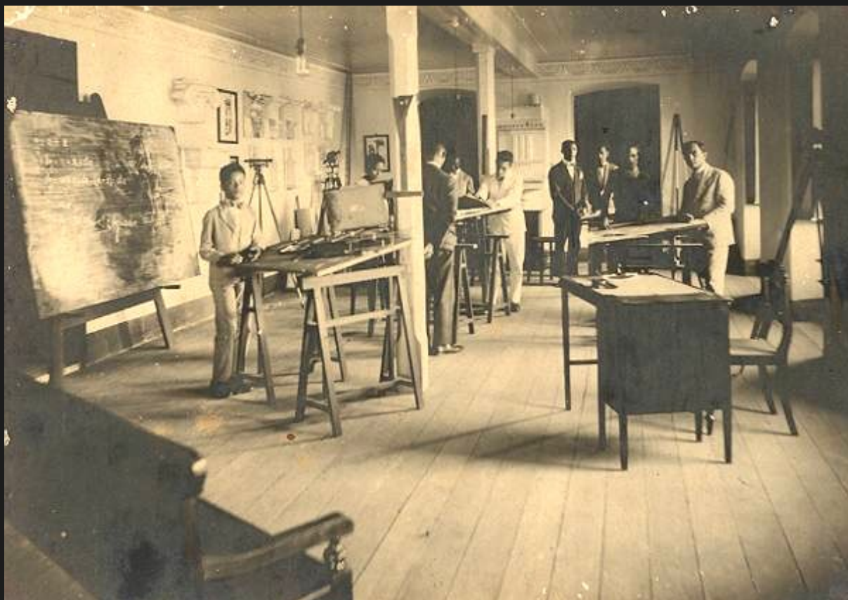
Figura 9 - Aula de Arquitetura na Escola de Belas Artes da Bahia – Rua 28 de Setembro - Salvador/Bahia. Arquivo da EBA/UFBA.
