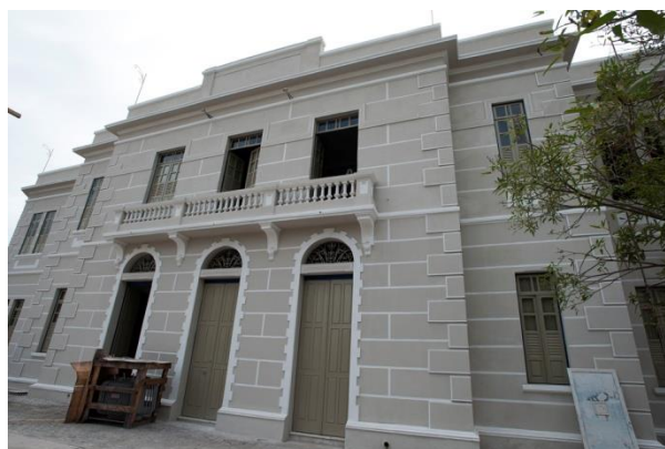
Figura 03 – Prédio da Alfândega. Fonte: Prefeitura de Aracaju
