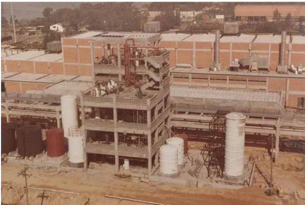
Obras de ampliação da fábrica em 1982
