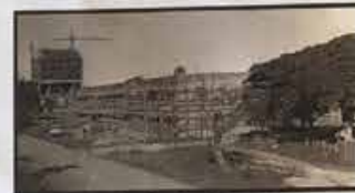
Obras do prédio da administração: antes dele, escritórios funcionavam em Porto Alegre. Ao fundo, a caldeira de recuperação sendo erguida
