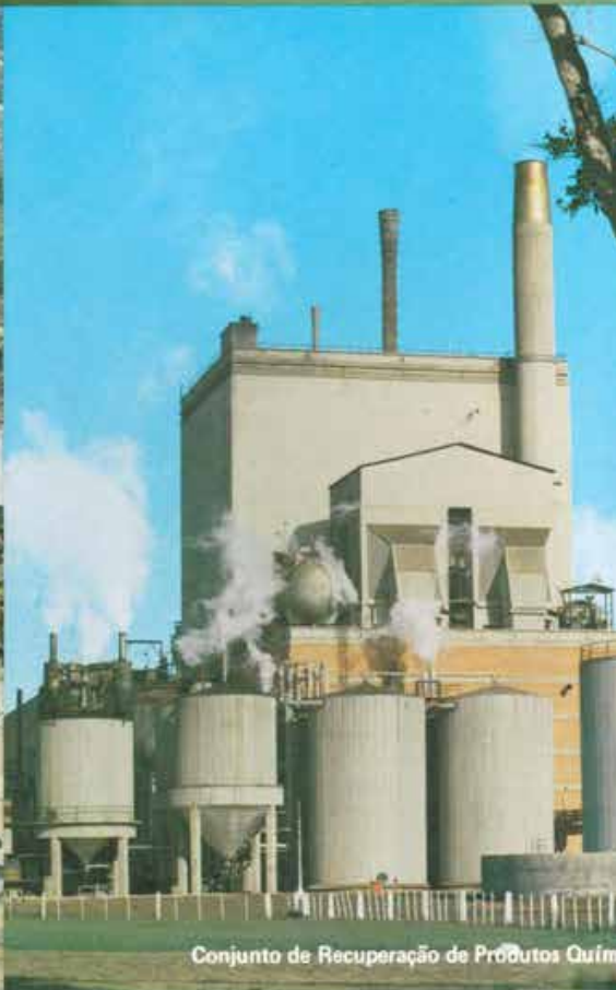
Forno de Cal e Tanques de Caustificação
