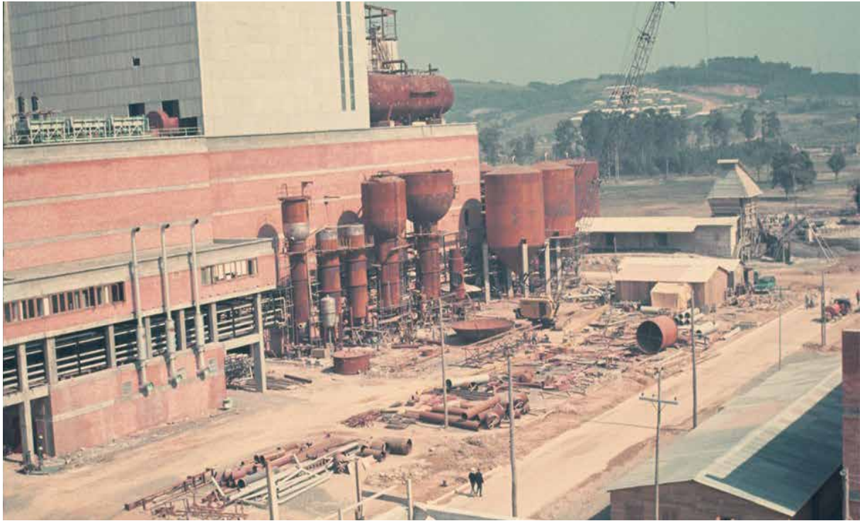
Evaporadores de licor preto em fase de montagem
