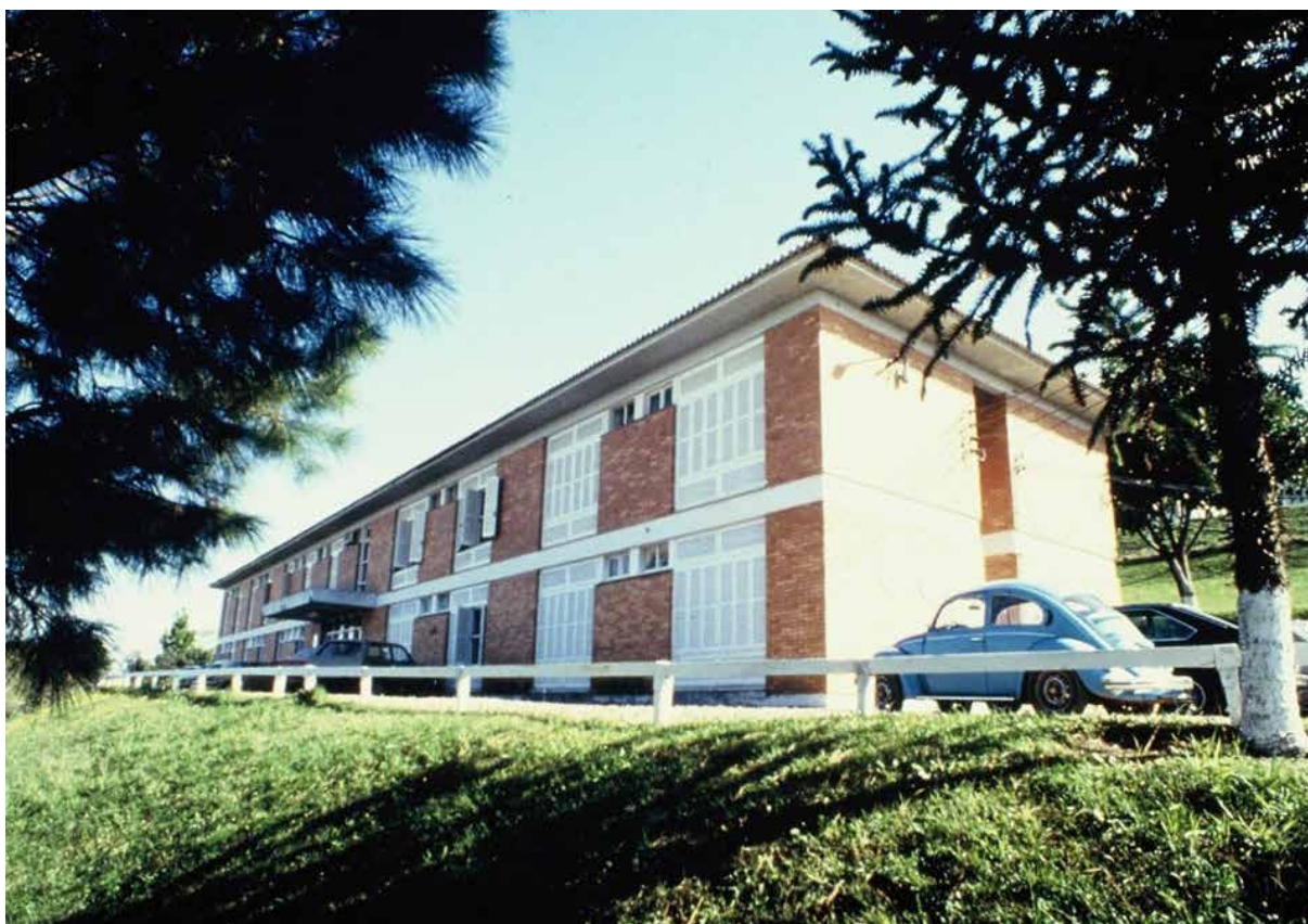
A vila residencial era constituída de inúmeras casas individuais e um prédio chamado de hospedaria
