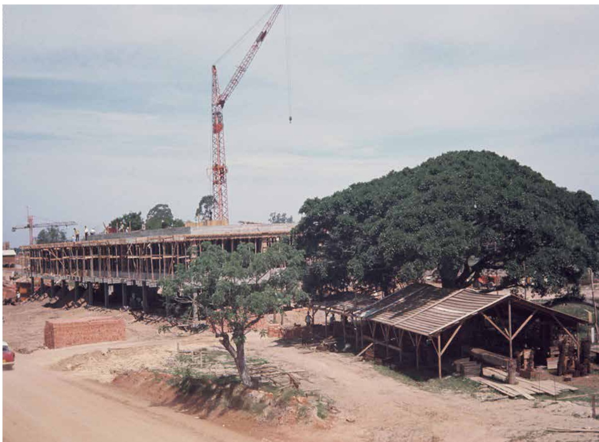
Construção do Prédio Administrativo em 1970
