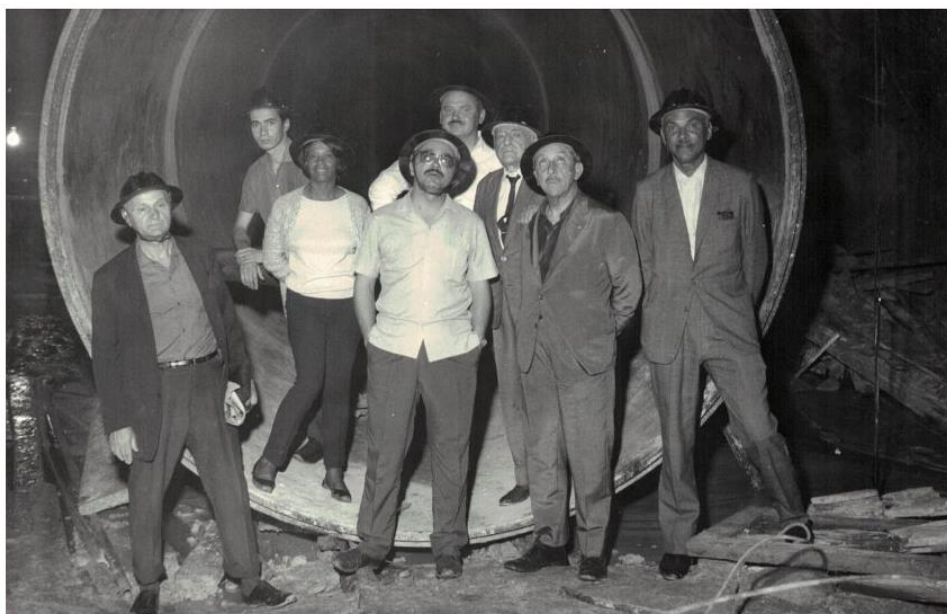
Imagem 03: Enedina, engenheiros e autoridades, Obras da Usina Capivari-Cachoeira
