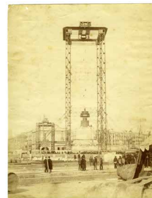
Construction of the Columbus Monument in Barcelona, 1888 Construcció del Monument a Colom a Barcelona, 1888
