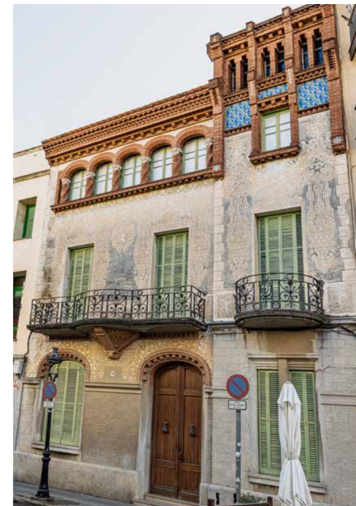
The architect Pere Domènech was commissioned by industrialist Joaquim Floris i Codina to build Can Floris (1917-1919) Can Floris (1917-1919) és un edifici construït per encàrrec de l'industrial Joaquim Floris a l'arquitecte Pere Domènech
