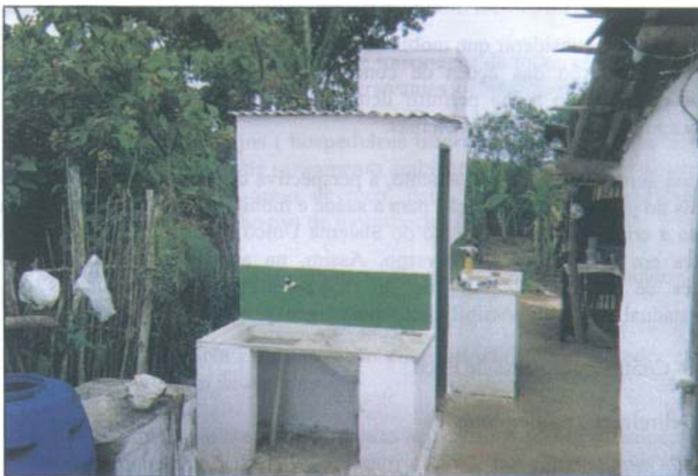
Fig. 11 - Módulo Sanitário - Vila Castelo Branco/Itaquara/BA
