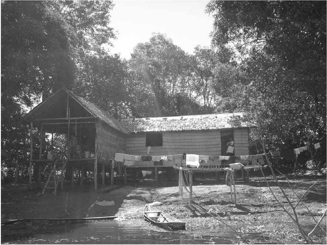
Ilustração 8 - Casa de palha. Vistas da fachada e interior da varanda.
