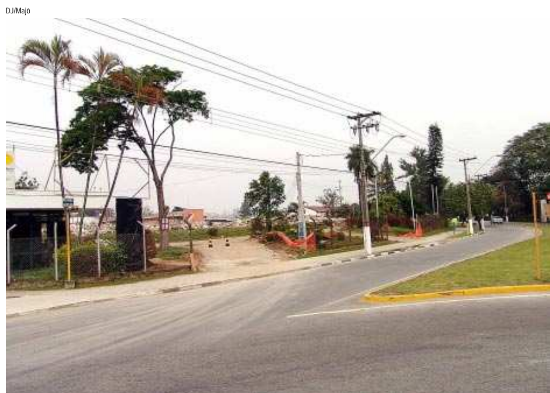
Ainda em fase de demolição, a previsão é de que as obras terminem em agosto deste ano. Cerca de 220 vagas de emprego foram abertas
