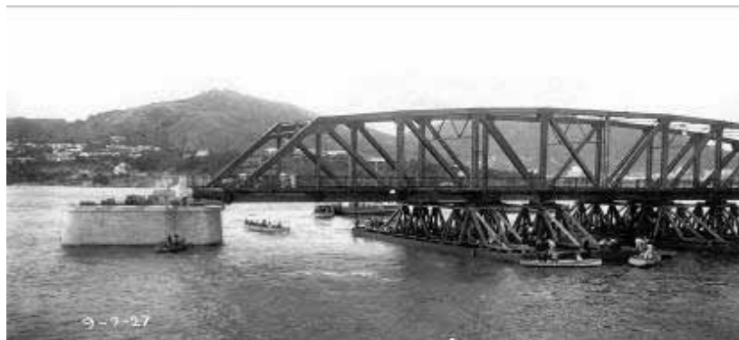
Fotografia 2 – Arquivo 000065 - Construção da Ponte Florentino Avidos (Cinco Pontes). Data: 1927. Sem autoria conhecida. Fonte: Arquivo Geral do Município de Vitória
