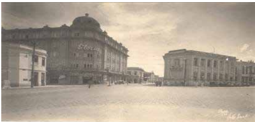
Fotografia 5 – Arquivo 005561 – Cine Glória, em frente, Banco Hipotecário e Agrícola do Estado de Minas Gerais, à Avenida Jerônimo Monteiro. Data precisa: 1936. Autor: Paes. Fonte: Arquivo Geral do Município de Vitória
