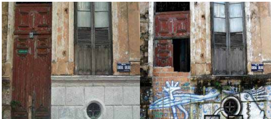
Fachada de residência, General Gurjão/2008
