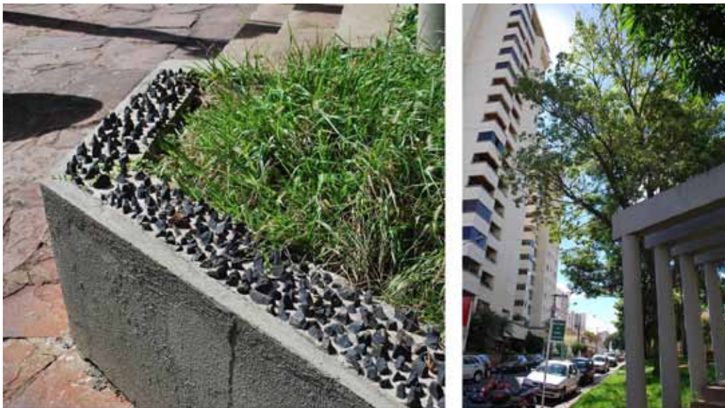
Fig. 4 – fotografias da Praça Doutor Duarte, em Uberlândia (MG). Imagem à esquerda: detalhe da mureta modificada, com britas cravadas em suas bordas, impedindo que pessoas se sentem nas mesmas. Imagem à direita: a praça e alguns prédios de luxo que a circundam. Fotos de Paulo Rogério Luciano.
