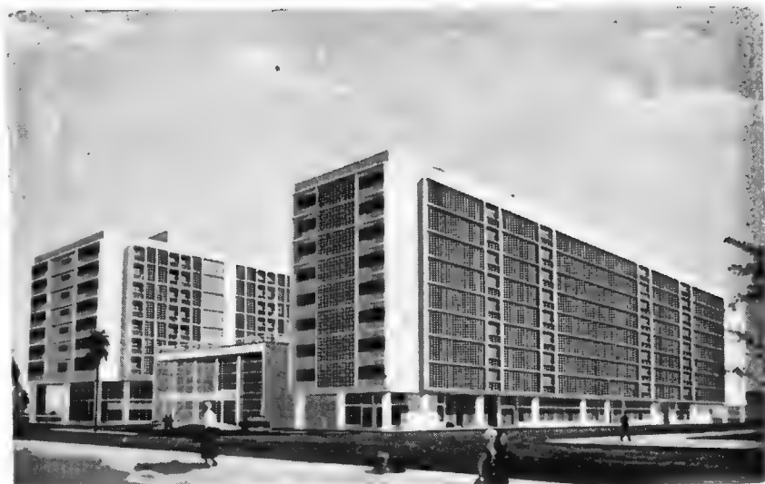
Cine-Hotel Consórcio de Bagé (em construção) Vista parcial.
