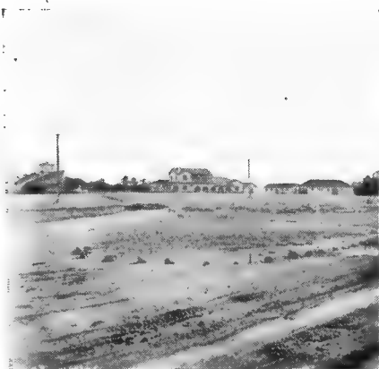
Vista geral, vendo-se o pavilhão principal.
