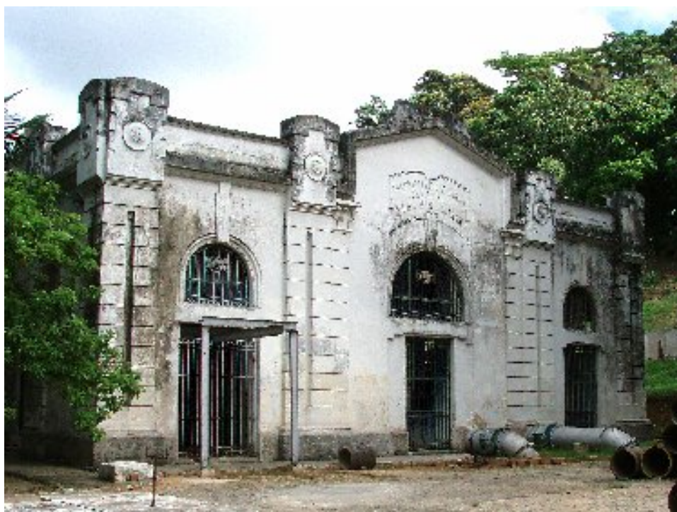
Figura 81: Casa dos filtros em Gurjaú – Cabo de Santo Agostinho – PE. Fonte: acervo do autor.
