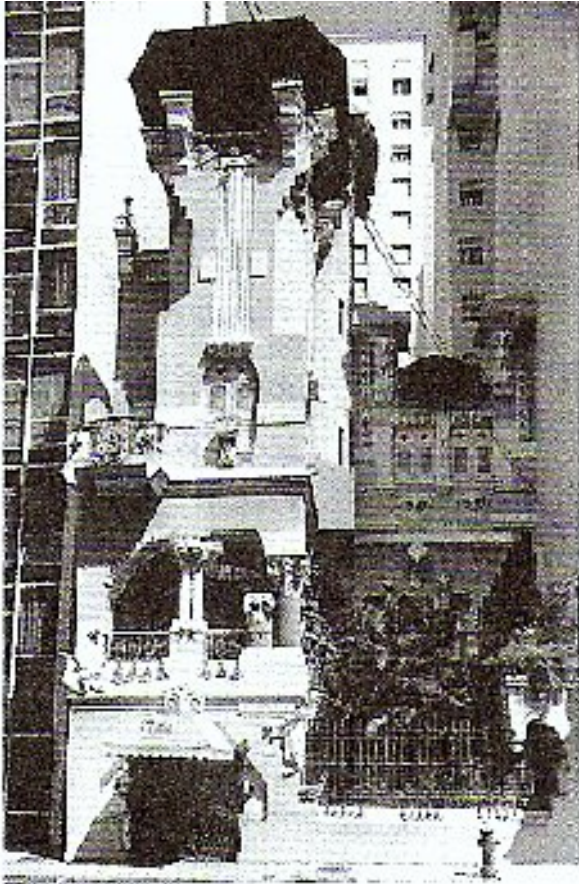
Figura 48: (1.7.1.3.5.2 – Edificação residencial. 1.7.1.3.5.2.3 – Vilino Silveira - Rio de Janeiro – RJ): Fachada do antigo Villino Silveira, rua do Russel, 734-Glória,RJ. Projeto de Antônio Virzi. CZAJKOWSKI, Jorge. Org. Guia da Arquitetura Eclética no Rio de Janeiro. Rio de Janeiro: Centro de Arquitetura e Urbanismo, 2000.
