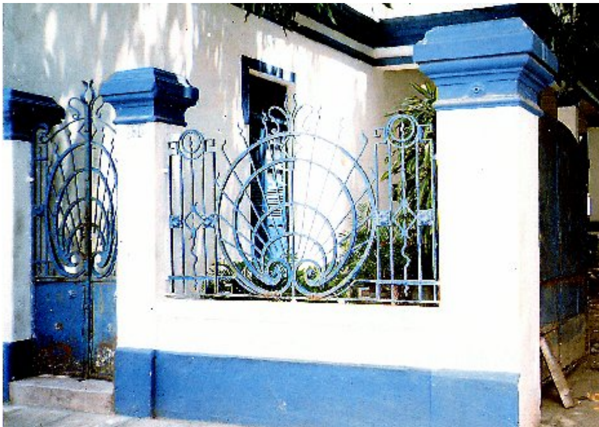
Figura 132: Detalhe do gradil da Pousada Paris à Rua do Riachuelo, 630, Boa Vista – Recife - PE. Crédito fotográfico: acervo do autor.
