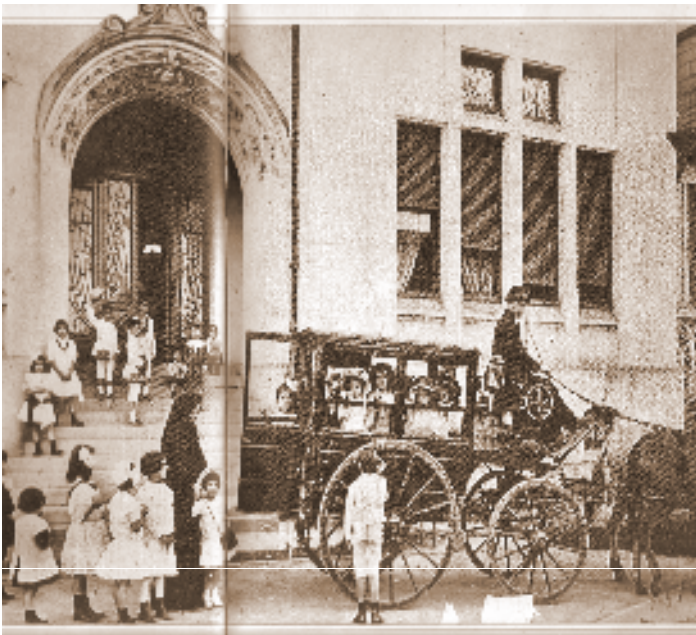
Figura 44: (1.7.1.3.5.1 – Edificação pública. 1.7.1.3.5.1.2– Colégio des Oiseaux - São Paulo – SP): Colégio des Oiseaux em estilo Art Nouveau. São Paulo - SP. (Foto: Lourdes de Alcântara Machado (Cedente para Nosso Século). (NOSSO SÉCULO, 128/9:1980)
