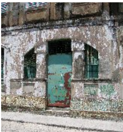
Figura 85: Detalhe da fachada da edificação à rua dos Coelhos, 222. Bairro dos Coelhos – Recife – PE. Fonte: acervo do autor.
