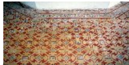
Figura 97: Detalhe do piso residência à Rua Dom Bosco, nº 779. Bairro da Soledade – Recife – PE. Fonte: acervo do autor.
