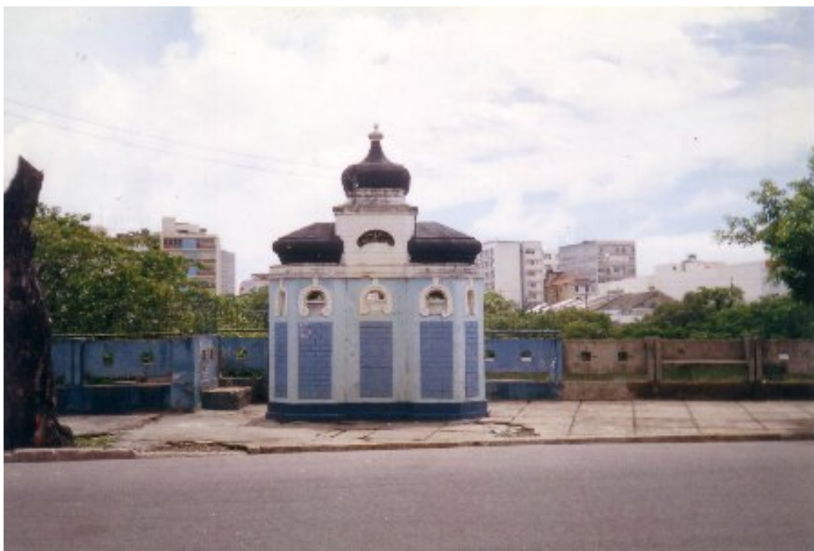
Figura 73: Pavilhão Sanitário. Rua Dr. José Mariano, s/n. Bairro da Boa Vista – Recife – PE. Crédito fotográfico: acervo do autor.
