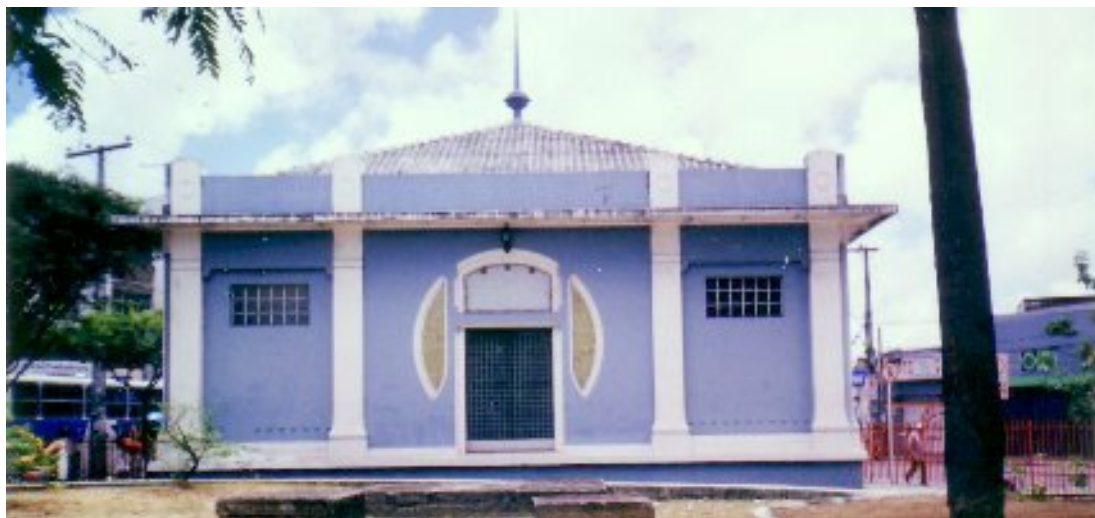
Figura 72: Estação Elevatória. Largo da Paz. Bairro de Afogados – Recife – PE. Crédito fotográfico: acervo do autor.
