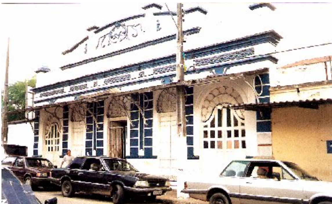
Figura 140: Cine-teatro em Timbaúba - PE Crédito fotográfico: acervo do autor.
