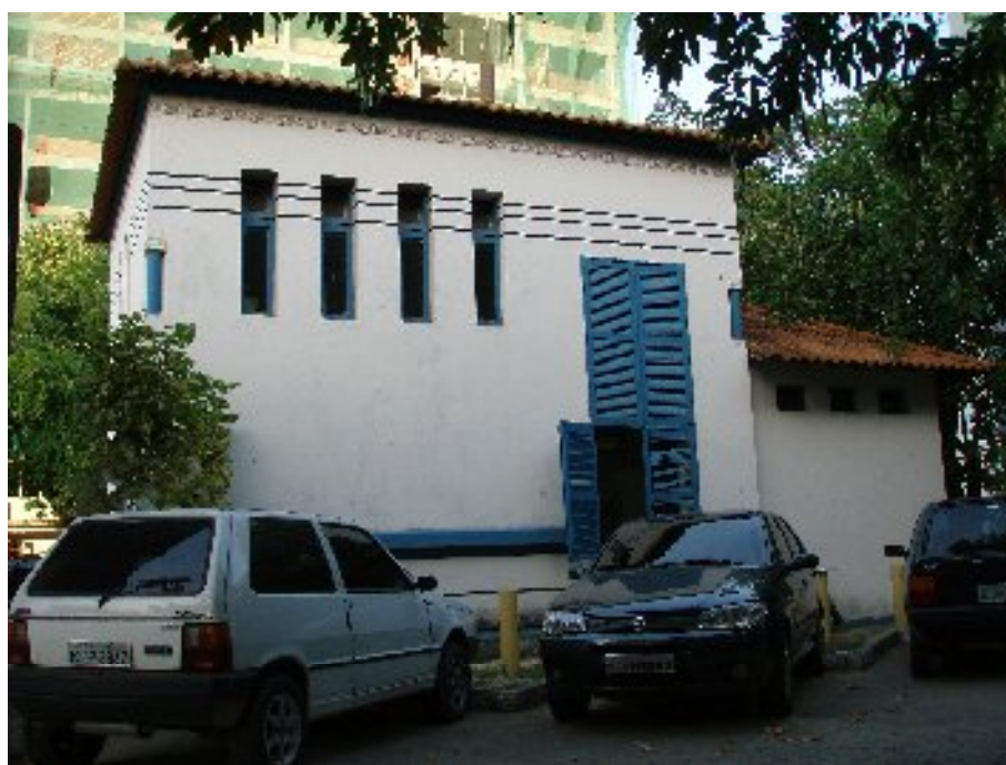
Figura 78: Estação Elevatória de Esgotos na Rua da Aurora, pátio interno – Santo Amaro – Recife – PE. Fonte: acervo do autor.
