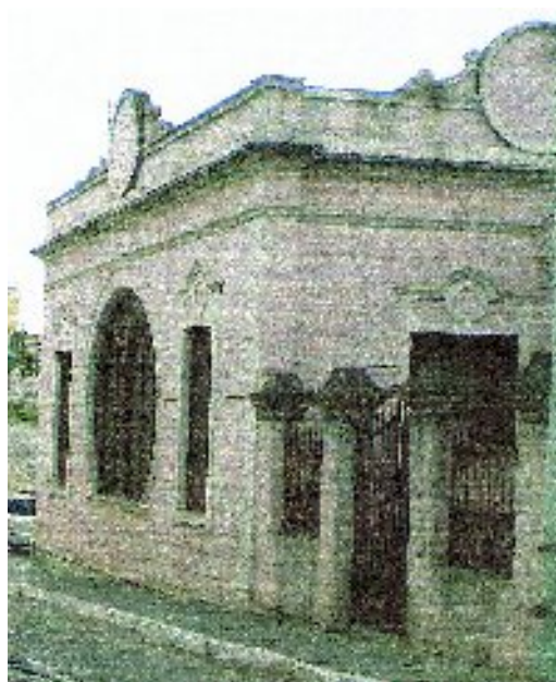
Figura 52: (1.7.1.3.5.2 – Edificação residencial. 1.7.1.3.5.2.4 – Residência – Penedo – AL): Fachada da residência situada em Penedos, Alagoas. Foto: José Luiz Mota Meneses.
