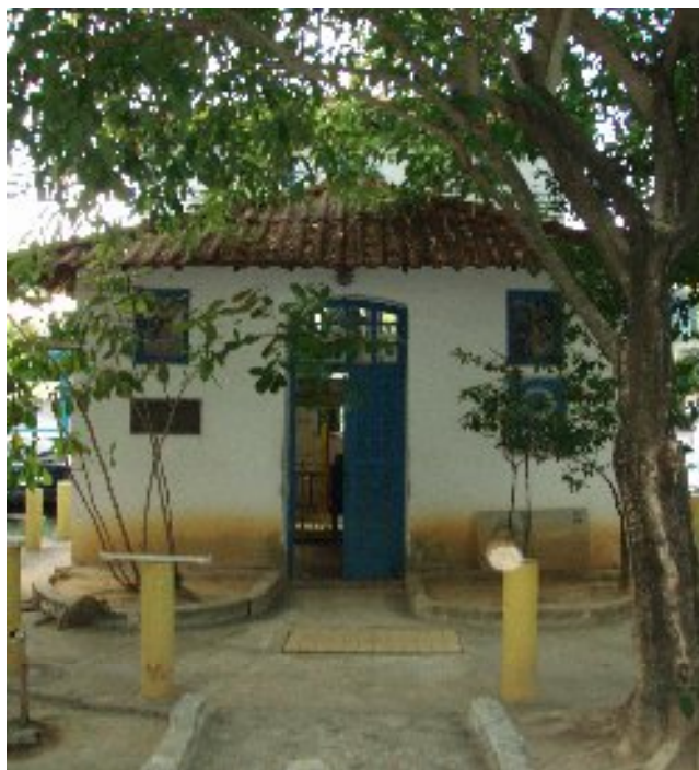
Figura 77: Estação Elevatória de Esgotos na Rua da Aurora, pátio interno – Santo Amaro – Recife – PE. Fonte: acervo do autor.
