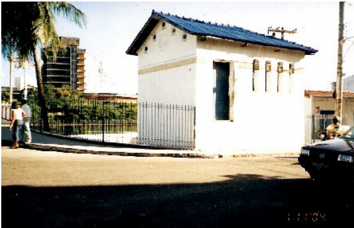
Figura 74: Estação Elevatória. Rua Dr. José Mariano, s/n. Bairro dos Coelhos – Recife – PE. Crédito fotográfico: acervo do autor.
