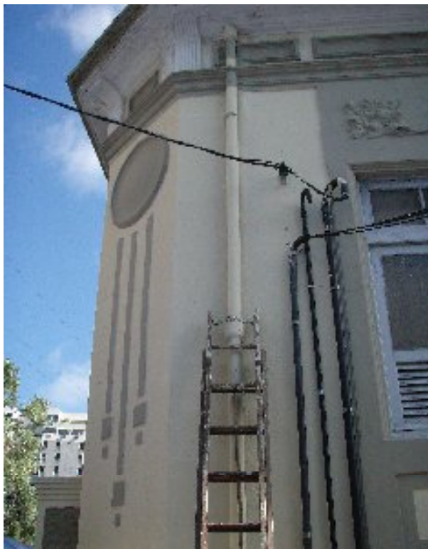
Figura 98: Detalhe da fachada da residência à Rua Dom Bosco, nº 779. Bairro da Soledade – Recife – PE. Fonte: acervo do autor.
