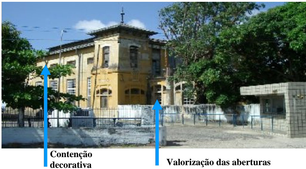
Figura 69: Vista da estação elevatória. Av. Saturnino de Brito, nº 472. Bairro do Cabanga – Recife – PE. Crédito fotográfico: acervo do autor.
