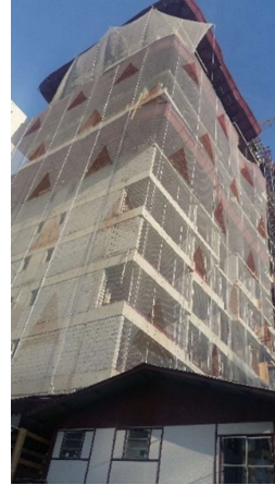
Figura 39. Exemplo de edifício em construção no bairro Vila Madalena na cidade de São Paulo (dez/2016): vedação externa em bloco de concreto. Fonte: acervo pessoal.
