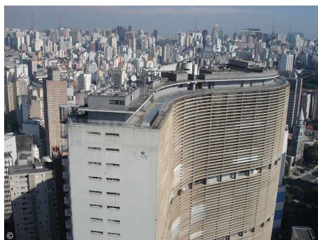
Figura 14. Topo do Edifício Copan. Fonte: BARATTO, 2014b.
