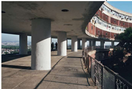
Figura 7. Edifício Pedregulho. Fonte: FRACALOSSO, 2011a (foto cortesia de Nabil Bonduki).
