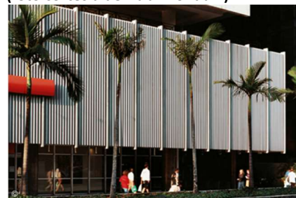
Figura 10. Marquises com sombreamento em brises verticais do edifício Sul-Americano. Fonte: FRACALOSSO, 2013 (foto de Nelson Kon).
