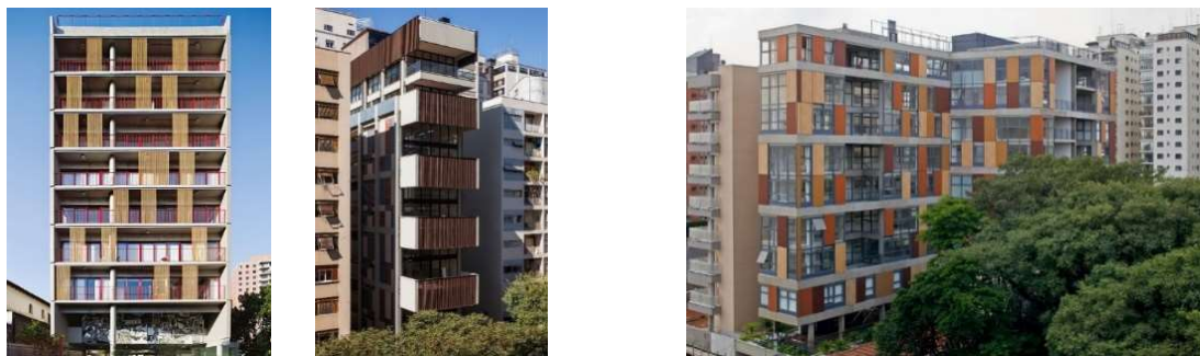
Figura 41. Edifícios da Incorporadora Idea!Zarvos. Da esquerda para a direita: Simpatia 236, Itacolomi 445, Fidalga 772. Fonte: Página eletrônica da Idea!Zarvos 8 .
