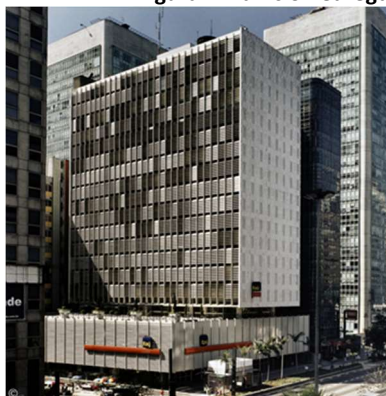
Figura 8. Edifício Sul-Americano. Fonte: FRACALOSSO, 2013 (foto de Nelson Kon).
