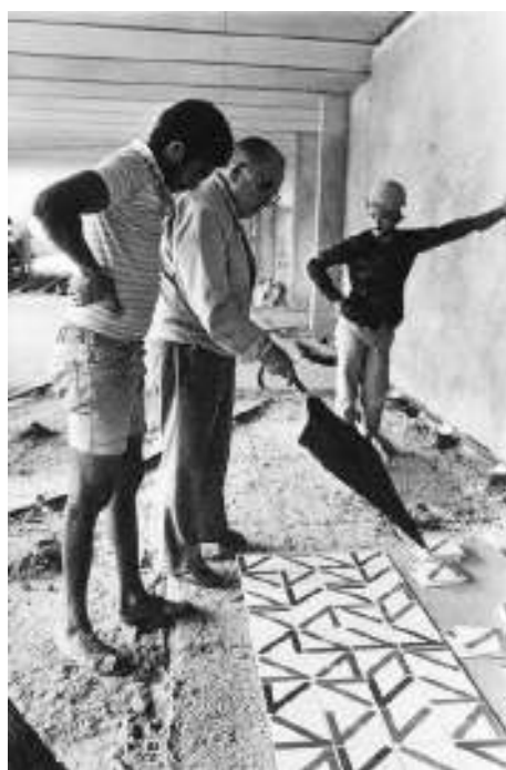
FIGURA 61 - Athos orientando funcionários na colocação os azulejos da obra do Hospital Sarah em Brasília. s/d. Fonte: Arquivo – Fundação Athos Bulcão
