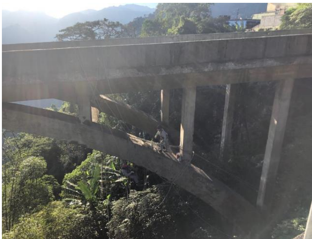
Figura 2 – Recuperação do Viaduto VI
