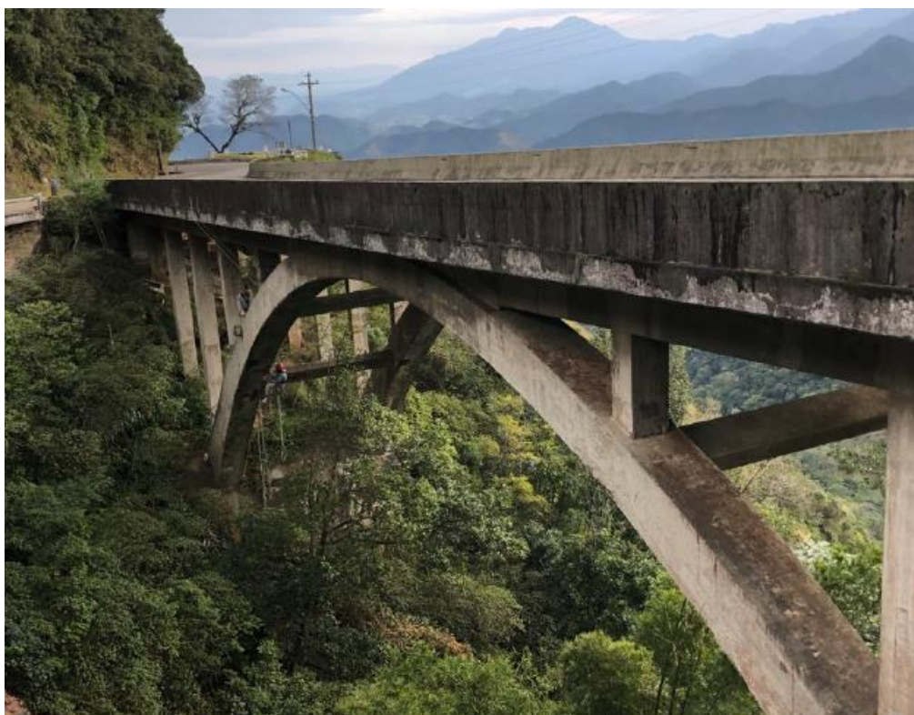
Figura 1 – Recuperação do Viaduto VI
