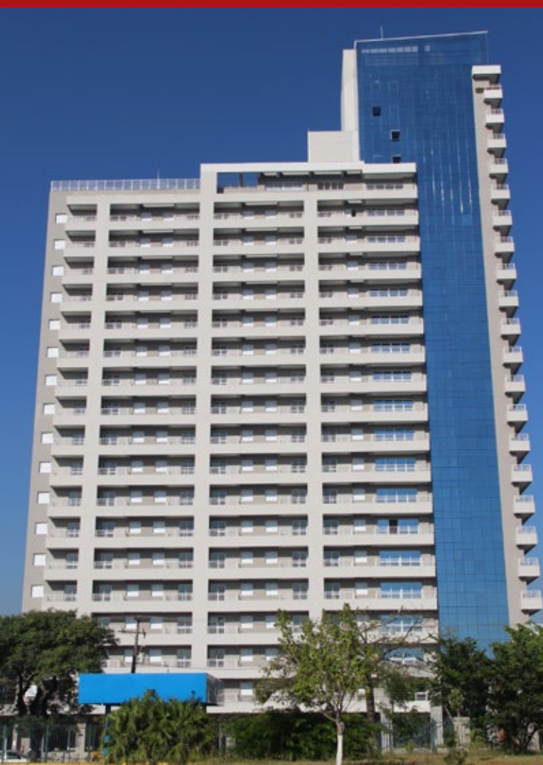
Marco Zero Tower/Home: lofts e salas comerciais em São Bernardo do Campo.
