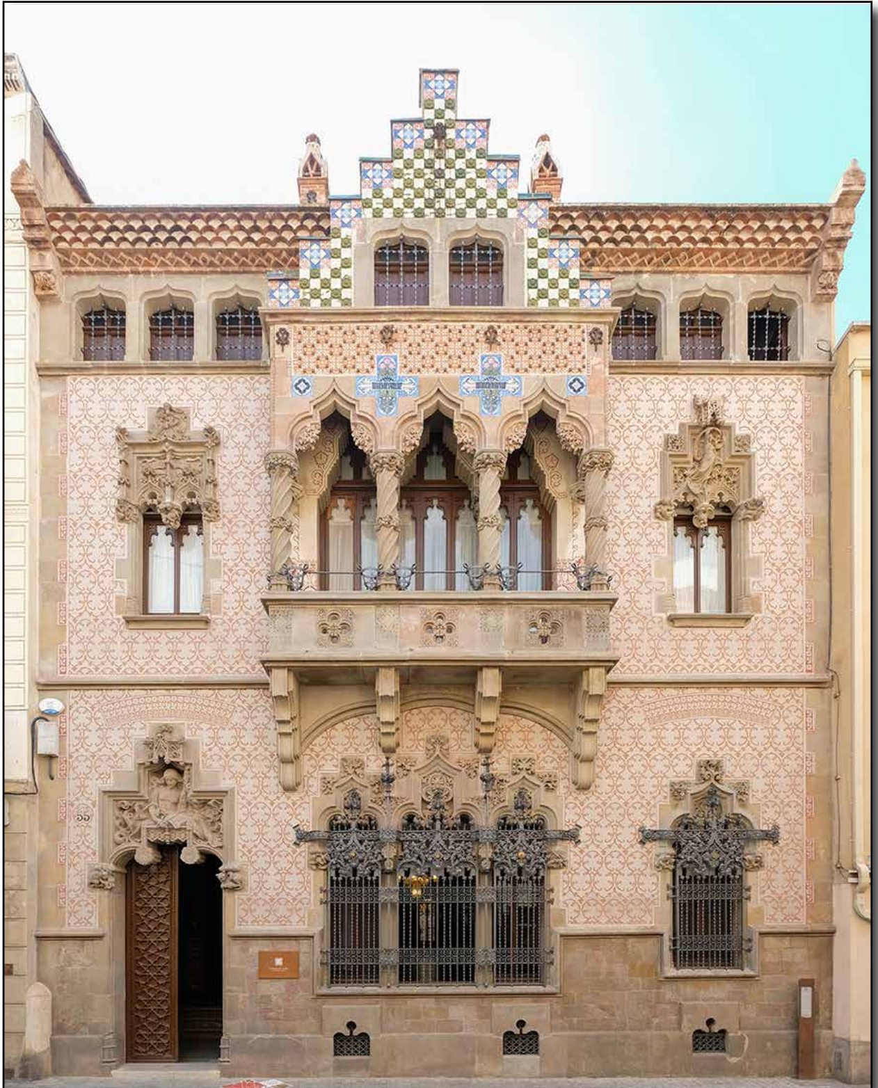
Casa Coll i Regàs: l'edifici.
